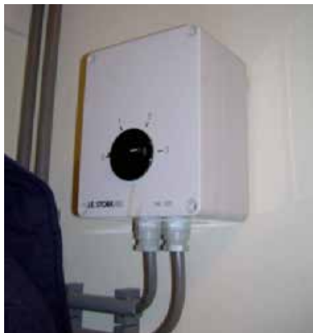
Figuur 6: Driestanden- schakelaar van een ventilatiesysteem - bron: W/E adviseurs
