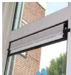
Figuur 2: Ventilatie-roosters (linksboven), toevoer balansventilatie (midden- en rechtsboven), afvoer ventilatielucht (onder) - bron: W/E adviseurs)
